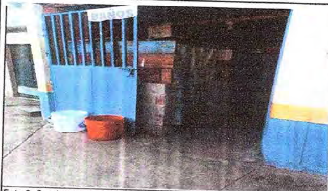
Foto 3: Sustitución de Baños
