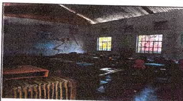
Foto 6: Sustitución de Láminas
