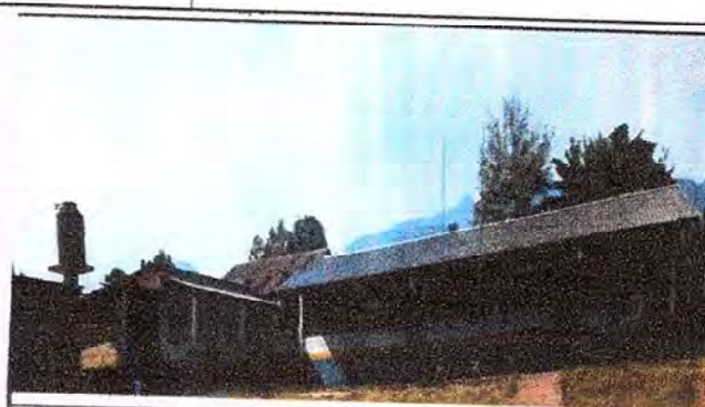
Foto 2: Pintura interior y exterior de la Escuela
